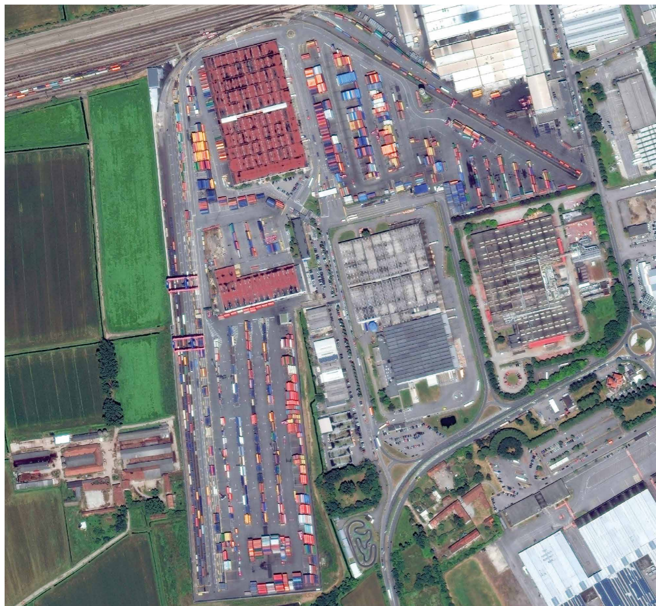
Der Verkehrsknotenpunkt für Bahntransporte zwischen den italienischen Seehäfen und Norditalien sowie Zentraleuropa: Rail Hub Milano in Melzo bei Mailand.
