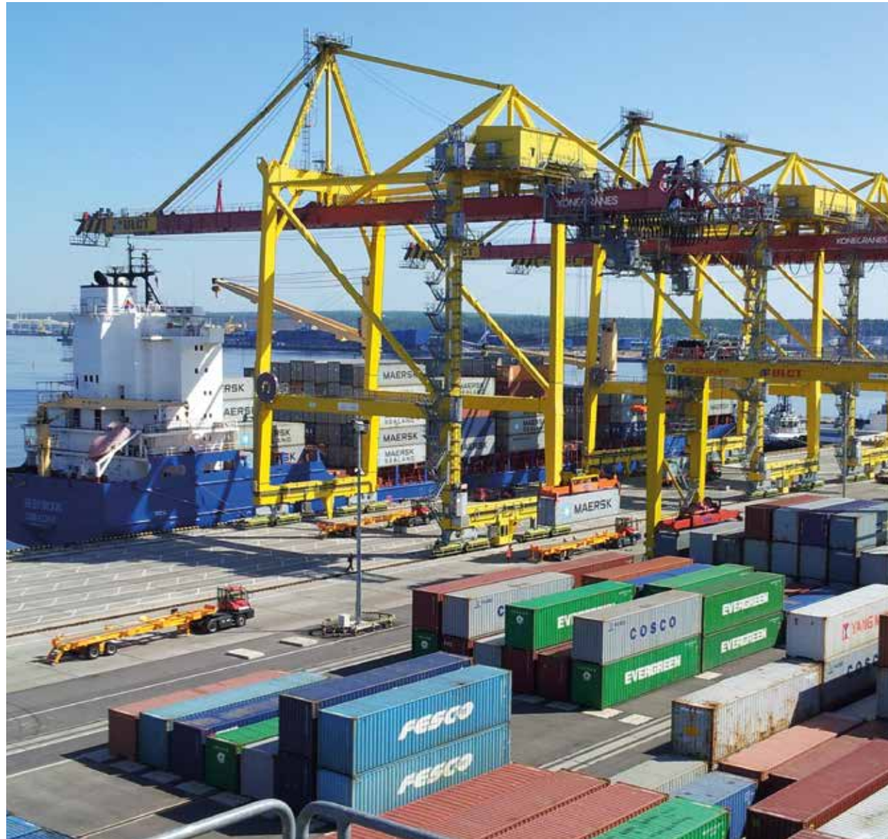
Der Ust-Luga Container Terminal in Russland hat im Jahr 2013 61.570 TEU umgeschlagen.
